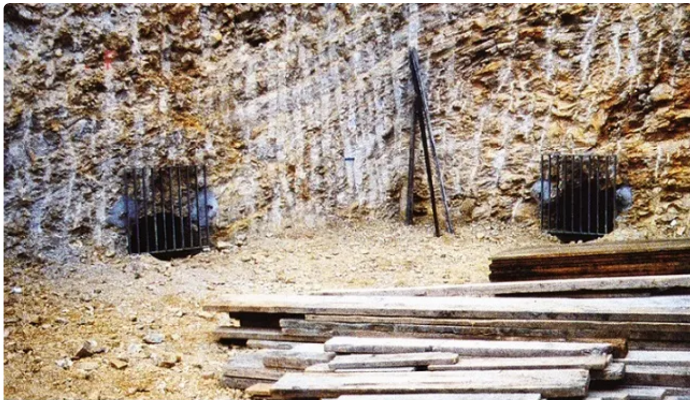
Localització de les galeries artificials durant la construcció de l'edifici
